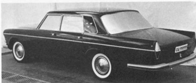
Der „358“ sollte ein sehr luxuriöses Auto mit vorderen Scheibenbremsen, Lenkradschaltung, Hinterrad-antrieb und pneumatischer Hinterradaufhängung sein, wie bei manchen Daimlern der Serie 300 (die gleiche Aufhängung wurde auch am Amazon als Experiment angebracht). Die Pläne mit einem 3,6 Liter-V8-Triebwerk wurden im Frühjahr 1959 verworfen und man entschied einen Sechszylinder als bessere, zeitgemäße und vor allem auch billigere Variante vorzuziehen.
